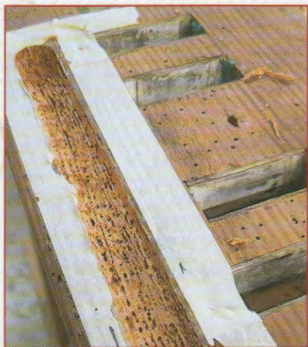
Für die Restaurierung vorbereitetes Stirnbrett der Pedalklavatur
